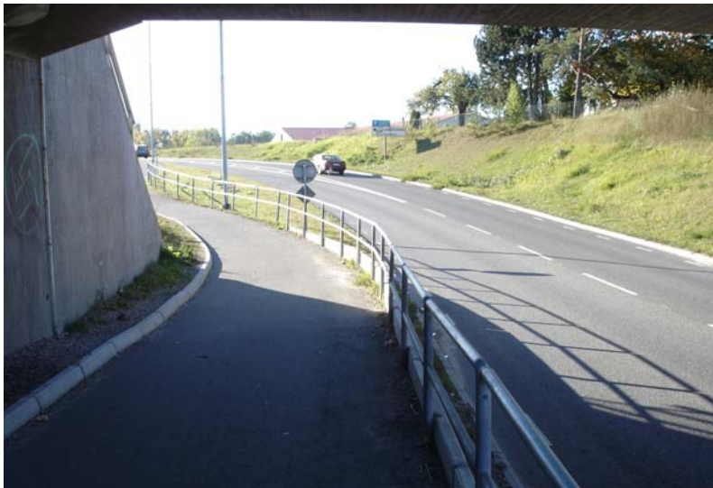
Figur 6.5 Gc-vägen under järnvägsviadukten, sikten söderut
