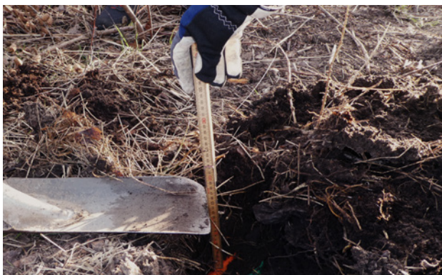
Mätning av nergrävd fiberkabel.
