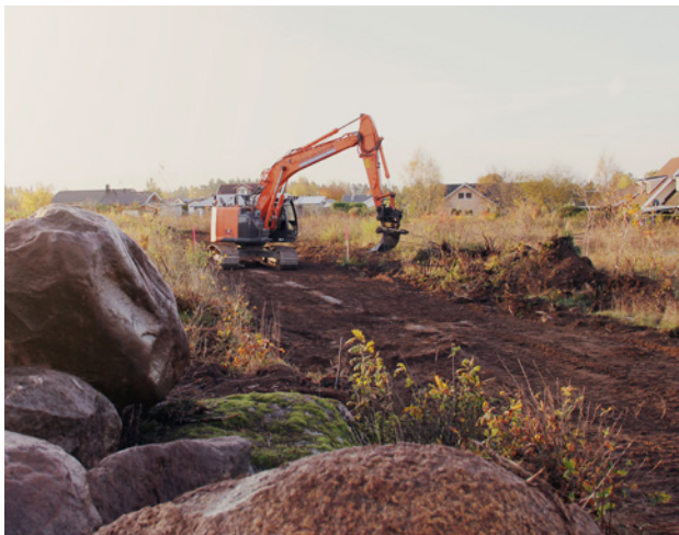
Arbetet med nya Aspvägen påbörjades under året.
