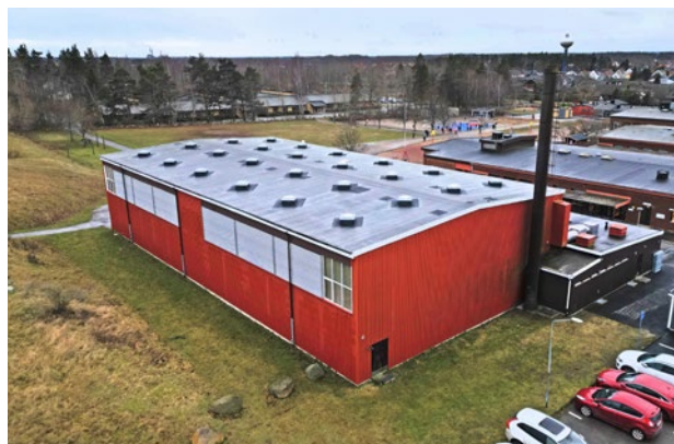
En av Sveriges första installationer av dagsljusledning i idrottshall.
