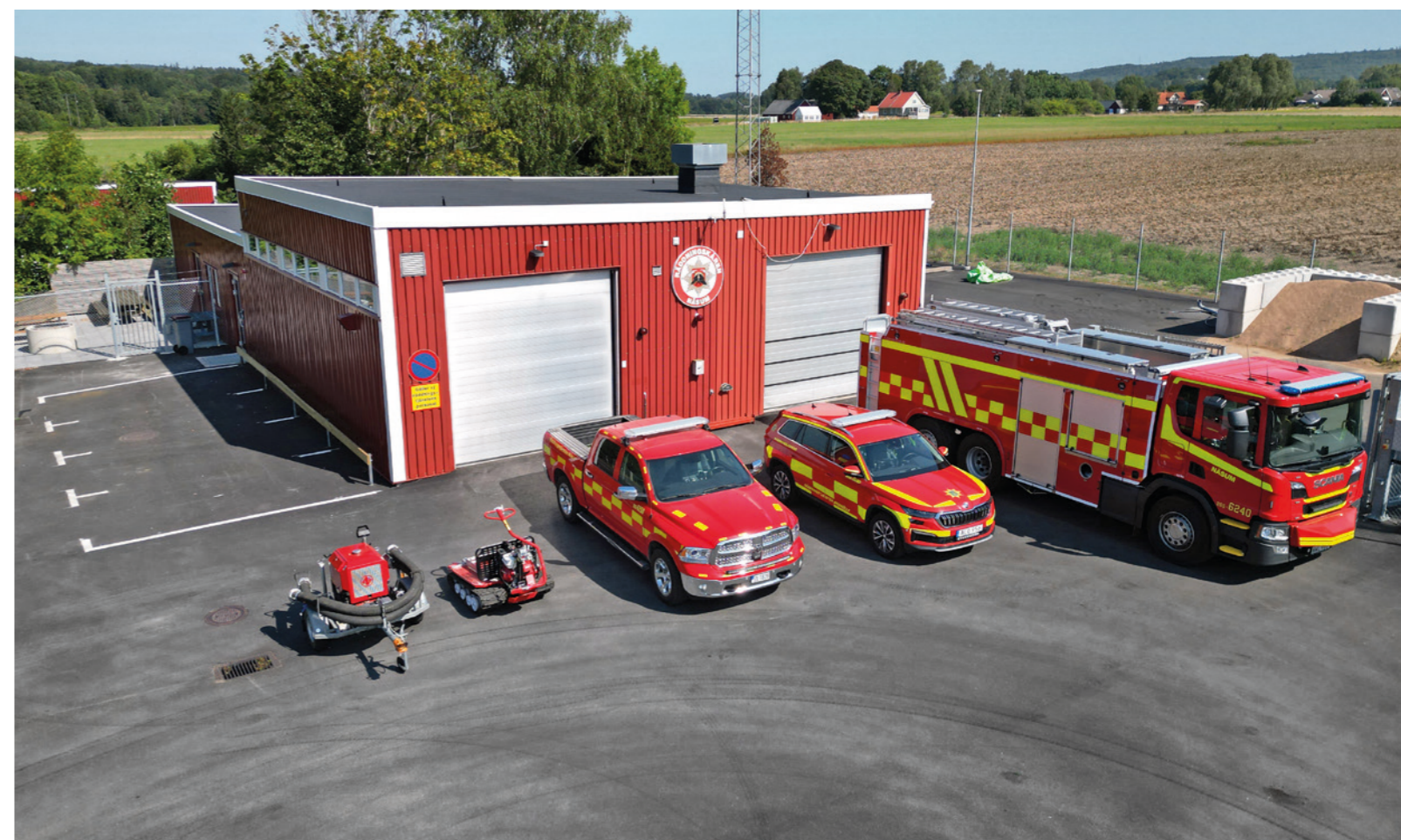
Lokalerna på brandstationen i Näsrum renoverades och vagnsparken förstärktes.
