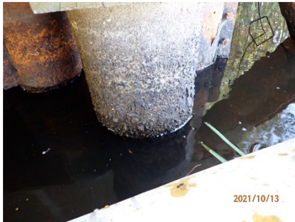
Bild 1 - Vittring betongpåle
