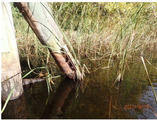
Bild 11 - Snedpåle med utbytt överdel
