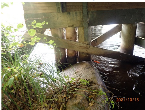
Bild 13 - Betongpåle med plaströr
