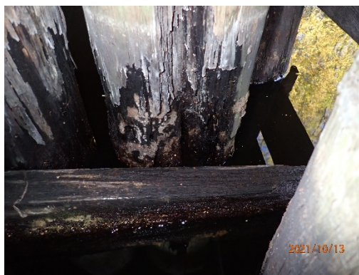
Bild 6 – Röta i pålen
