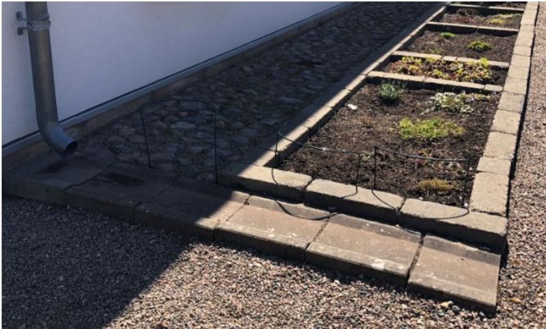
Figur 13. Exempel på ytlig avledning från stuprör via rännålar inne på fastighet ut mot gata. Mariastaden i Helsingborg. Foto: Tyréns AB.
