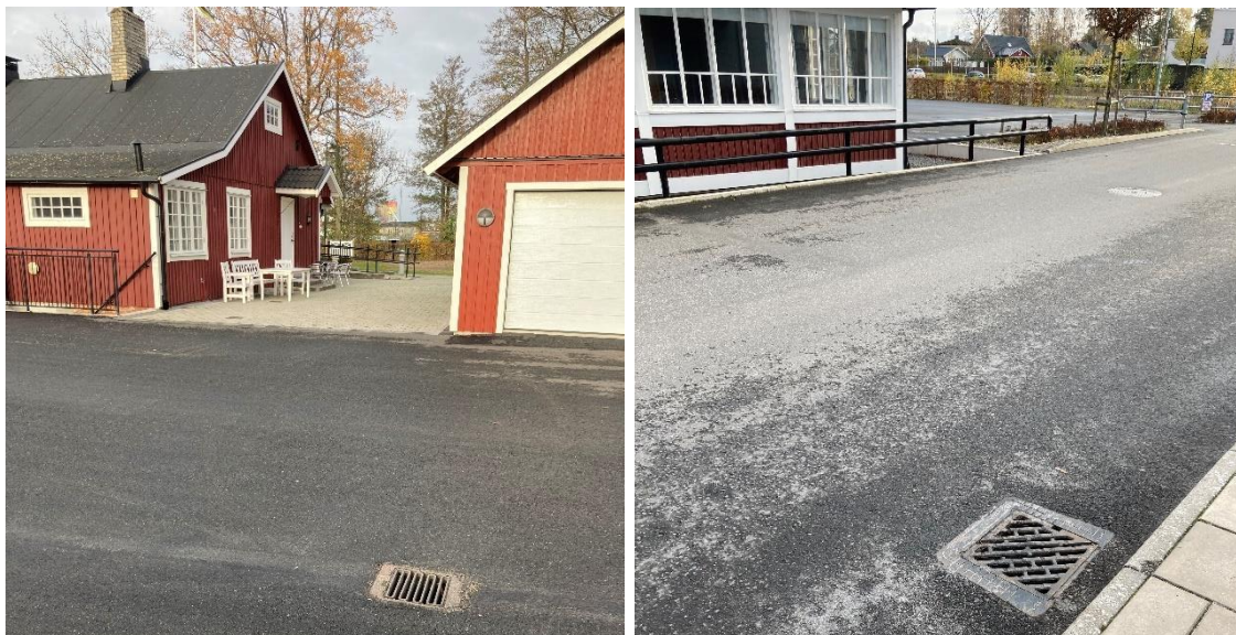
Figur 6. T.v. En av två rännstensbrunnar på parkeringen inom Trumpeten 2. I bakgrunden syns befintlig föreningslokal med stuprör kopplade direkt till ledningsnätet. T.h. Rännstensbrunn i Musikvägen utanför Trumpeten 2. Denna brunn är en av flera rännstensbrunnar i omkringliggande lokalgator. Foto från platsbesök (2022-11-09), Bromölla kommun.
