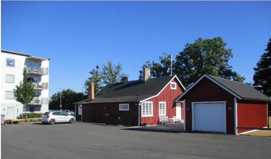
Strandstugan, vy från baksidan, parkeringsplatsen.
