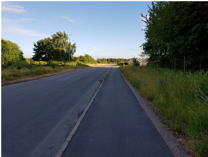
Östergatan mot söder.
