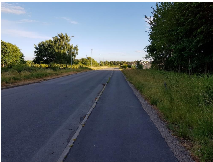
Östergatan mot söder.
