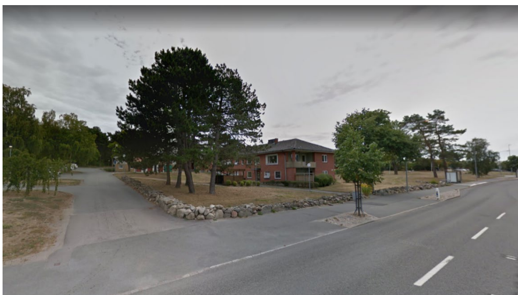
Vy över planområdet från nordväst. Tallplantering och avgränsande stenmur. Byggnaden är rivna.
