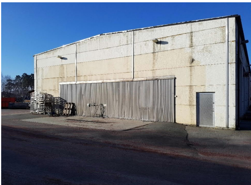
Figur 17. Foto över spolplatta vid den västra verkstaden. Foto från platsbesök 2019-02-28.
