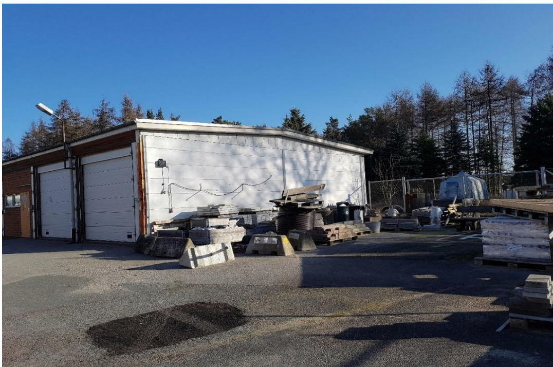
Figur 12. Foto över den östra verkstaden där olika lager av asfalt kan ses. Foto från platsbesök 2019-02-28.
