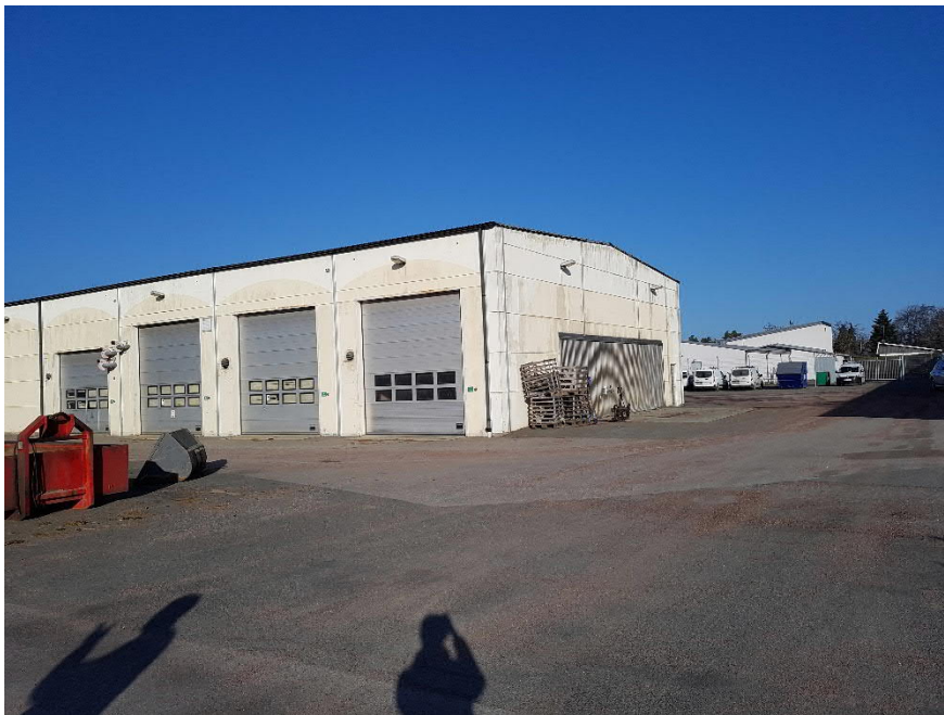
Figur 16. Översiktsbild av den västra verkstaden. Foto från platsbesök 2019-02-28.
