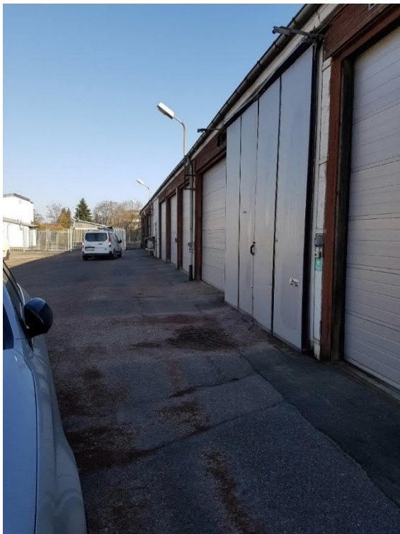
Figur 14. Fasadfoto från den östra verkstaden. Foto från platsbesök 2019-02-28.
