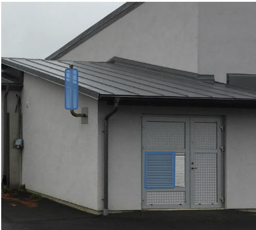
Figur 5. Åtgärder på reservkraftaggregat
