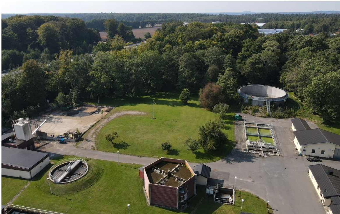
Delar av reningsverkets område idag med bla den klippta gräsmattan samt vegetation kring ån, sett från öster.
