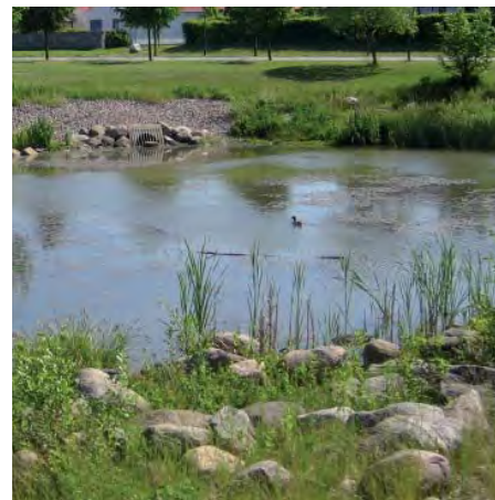
Exempel på dagvattendamm och svackdiken
