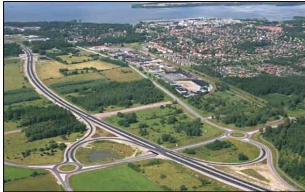
Nya verksamhetsområdet Åbylyckorna vid knutpunkten mellan väg E 22 och väg 116.
