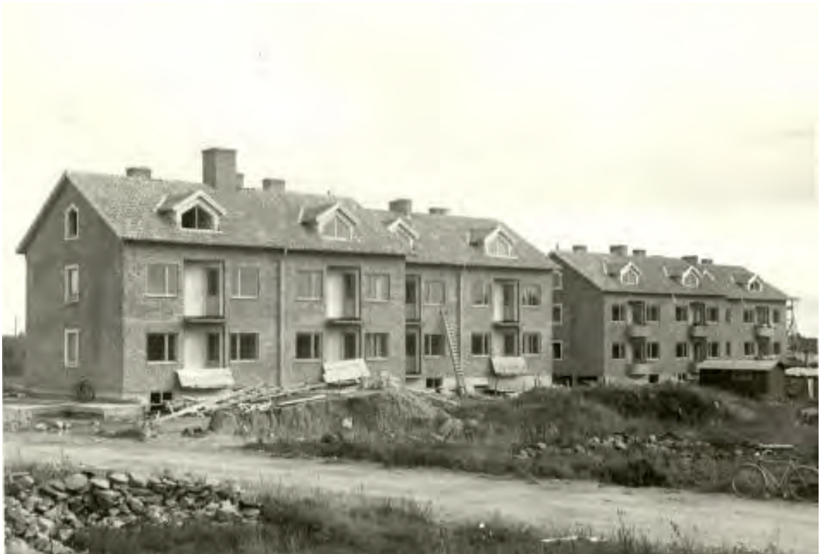
Bebyggelsen under uppförande 1950-51
