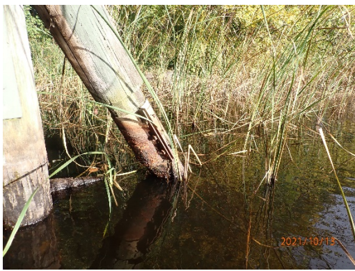
Bild 11 - Snedpåle med utbytt överdel
