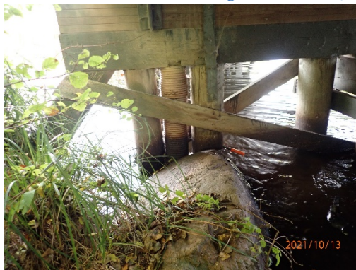
Bild 13 - Betongpåle med plaströr
