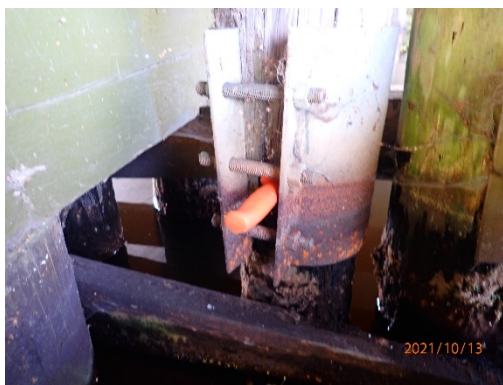
Bild 8 - Röta i pålen
