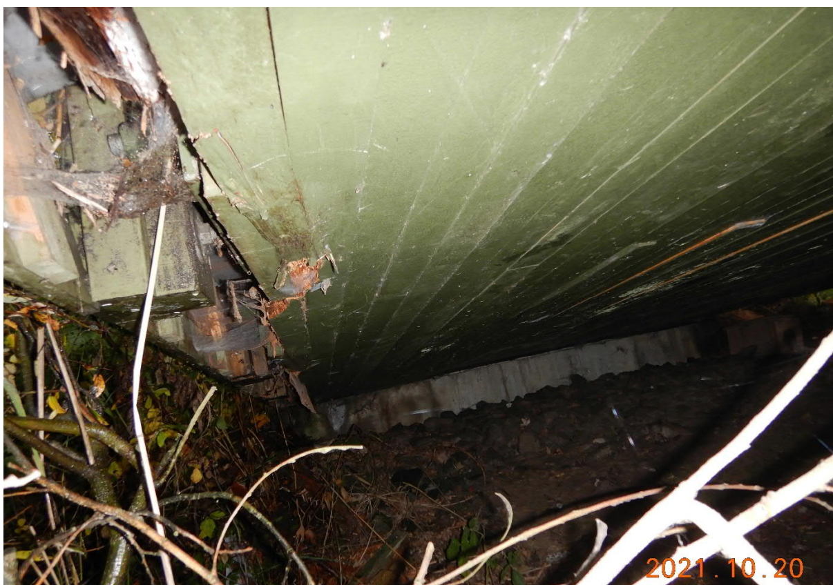
Foto nr 16, röta i plattsidor där spännstag sjunkit in i yttre lammeller
