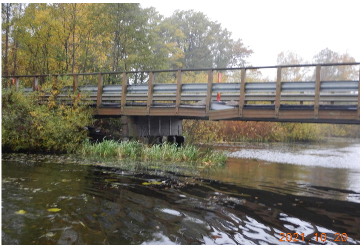
Foto nr 37, lös skyddspanel på plattsidor
