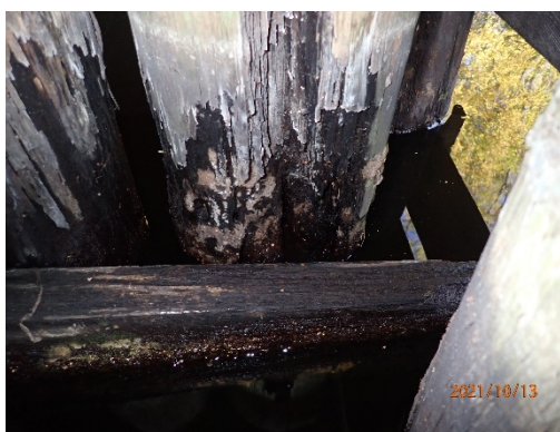
Bild 6 - Röta i pålen
