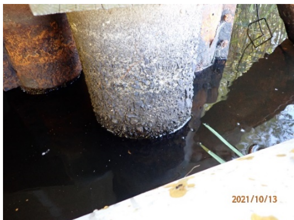
Bild 1 - Vittring betongpåle
