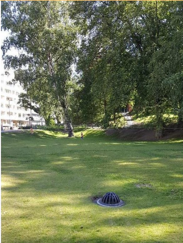
Figur 8. Torrdamm i parkmiljö.
