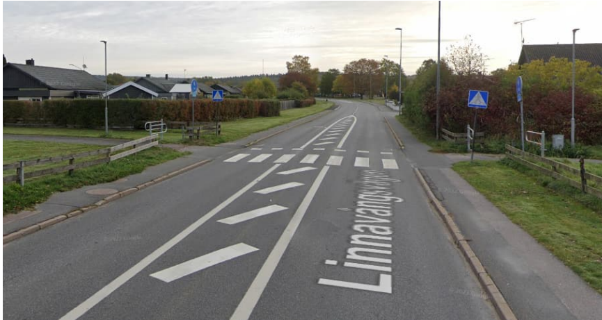
Figur 5 Passage för oskyddade trafikanter tvärs Linnavångsvägen. Källa: Google Maps.
