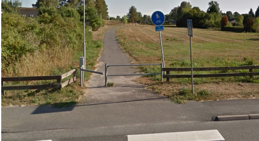
Figur 11 Staket/bom på gång- och cykelbanan i riktning söderut. Källa: Google Maps.
