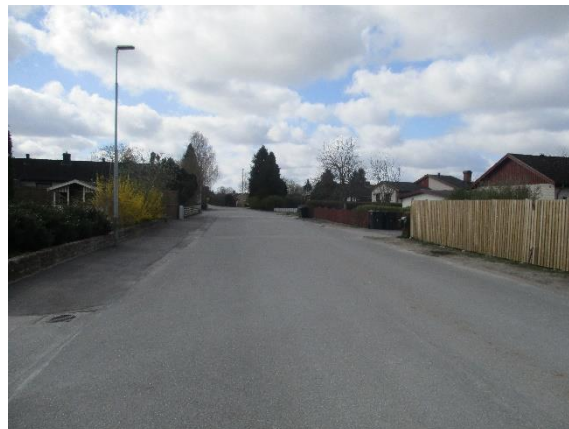
Figur 11. Forsavägen, sett från norr.
