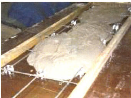
Betongen påförs med t ex en skyffel.
