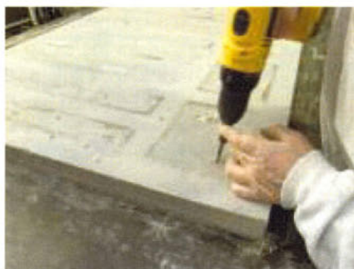
Montageskruvarna tas bort.
