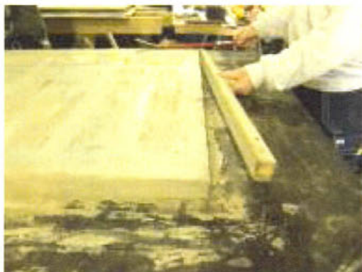
Ytterrampen tas bort.
