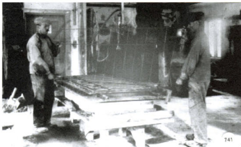
Arbetarna Herman Larsson (till vänster) och Anton Nilsson-Vendel lägger ner en 1/4 tums armeringsjärn i en staketform, till hälften fylld med cementbruk. Fotot taget efter 1928. Fotograf okänd. Bromölla kommun.
