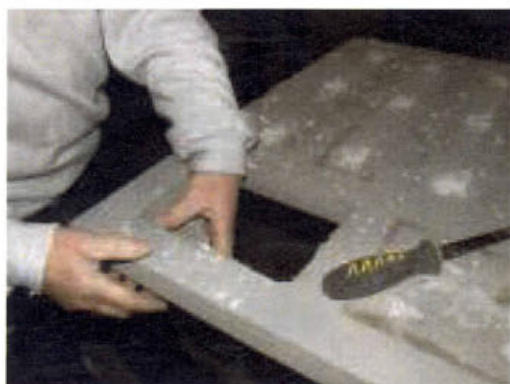
Cellplasten sågas och bryts ur.
