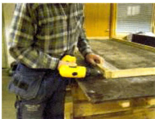
Sista skruven i ytterrampen.
