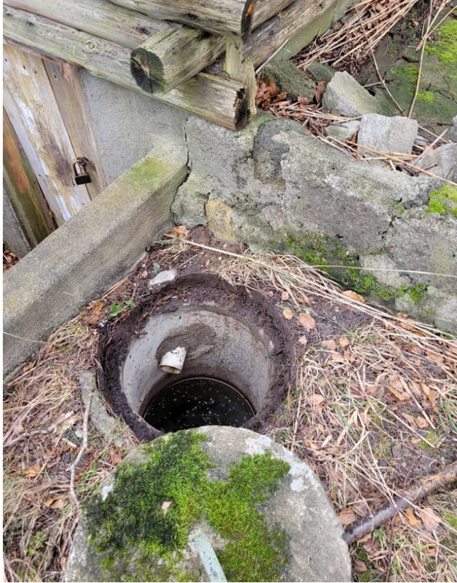
Figur 19. Avloppsbrunn i sydvästra hörnet av f.d. köket. Foto: Tyréns Sverige AB, 2023-12-19
