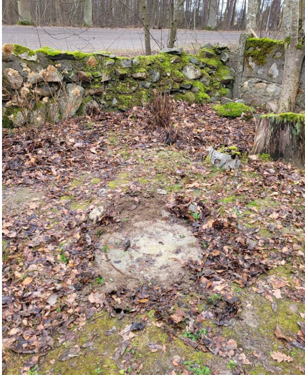
Figur 21. Pumpbrunn vid anslutning till kommunalt avlopp i nordöstra hörnet av fastigheten.
