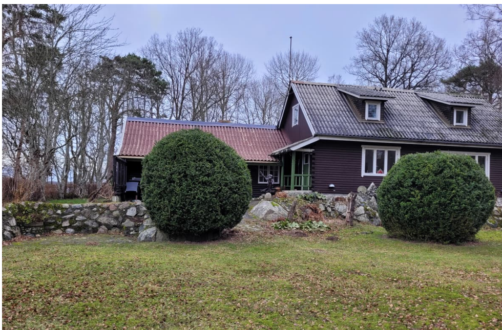
Figur 18. F.d. serveringen till vänster och 1½-plans huset till höger. Foto: Tyréns Sverige AB, 2023-12-19
